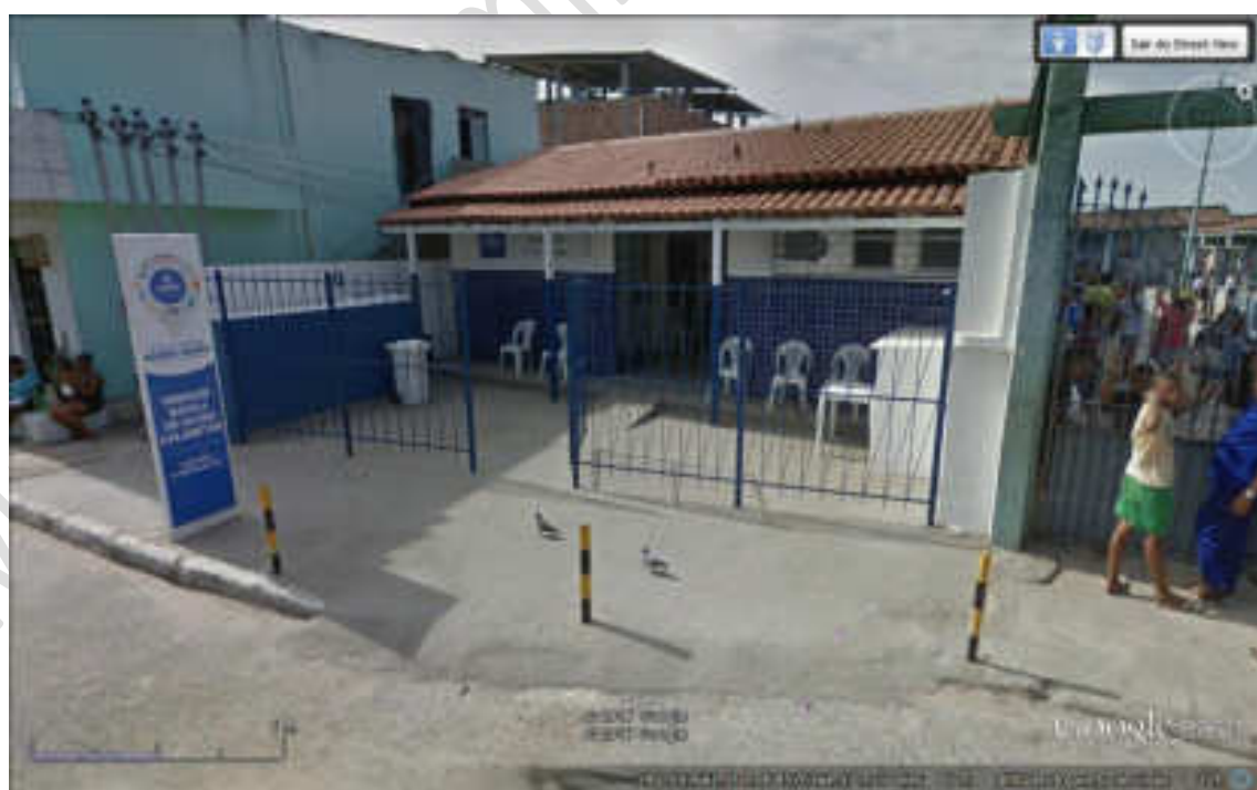
Fig. x – Aspectos ambientais urbanos / vista frontal
